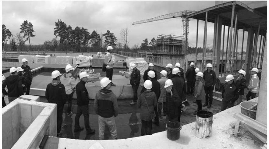
Hier entsteht der neue Gesundheitscampus des Rhön-Klinikums.
