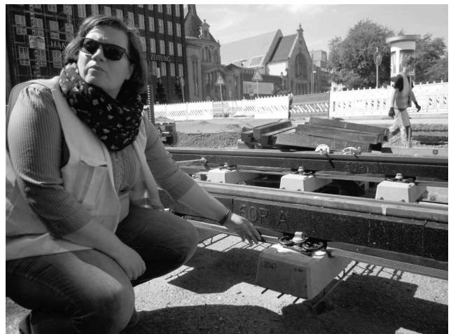
Arbeiten am Gleisbett.
