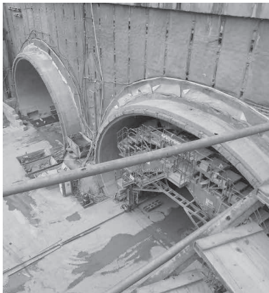
Bauarbeiten am Hbf Stuttgart © Klaus Haake
