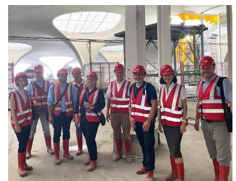
Besichtigung der Baustelle "Stuttgart 21".
