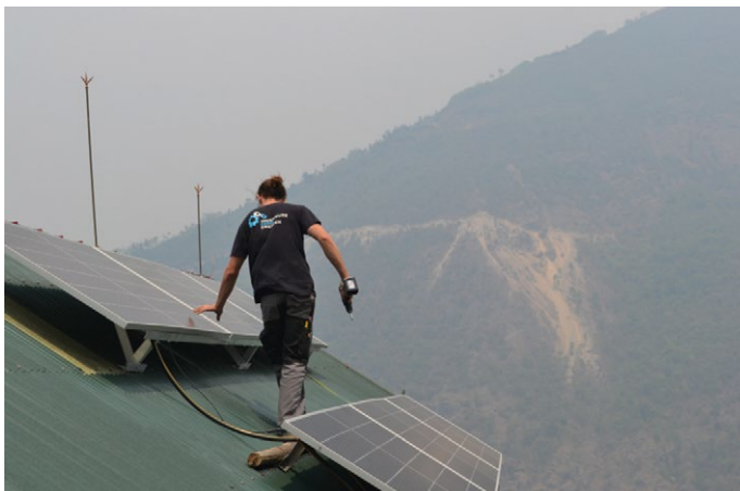
Das Bild zeigt einen Mitarbeiter von loG, der über das Dach der Schule klettert, um die PV-Anlage zu installieren
