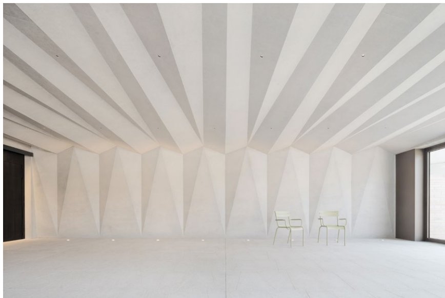
Sichtbeton-Faltungen in Sichtbeton (Bild: Brigida González)
