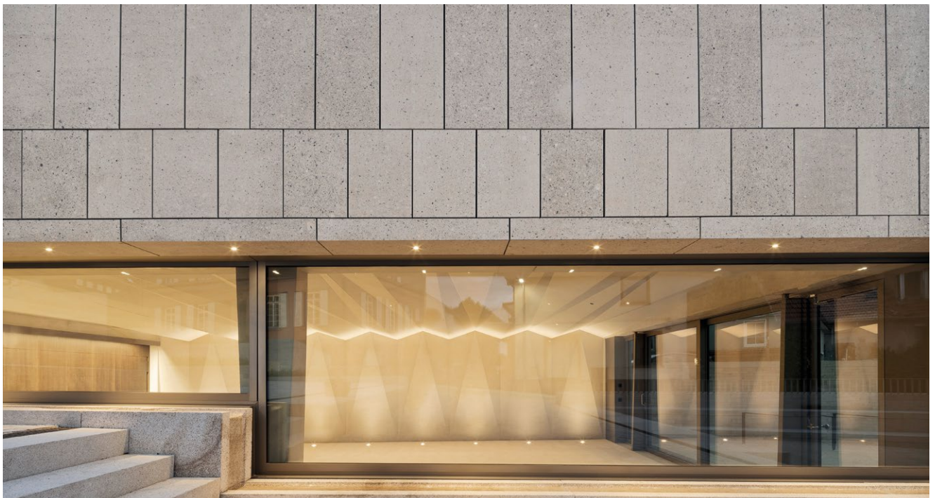
Neue Ortsmitte Gaiberg Gebäude von außen (Bild: Brigida González)
