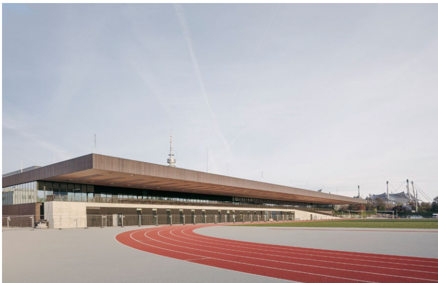
Das knapp 18,60 Meter weit auskragende Vordach über der Terrasse des Sportcampus der TU München zieht die Blicke auf sich. (Bild: Aldo Amoretti)
