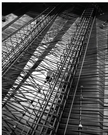
Schalung und Bewehrung für die Sichtbeton-Deckenkonstruktion (Bild: Ecker Architekten)
